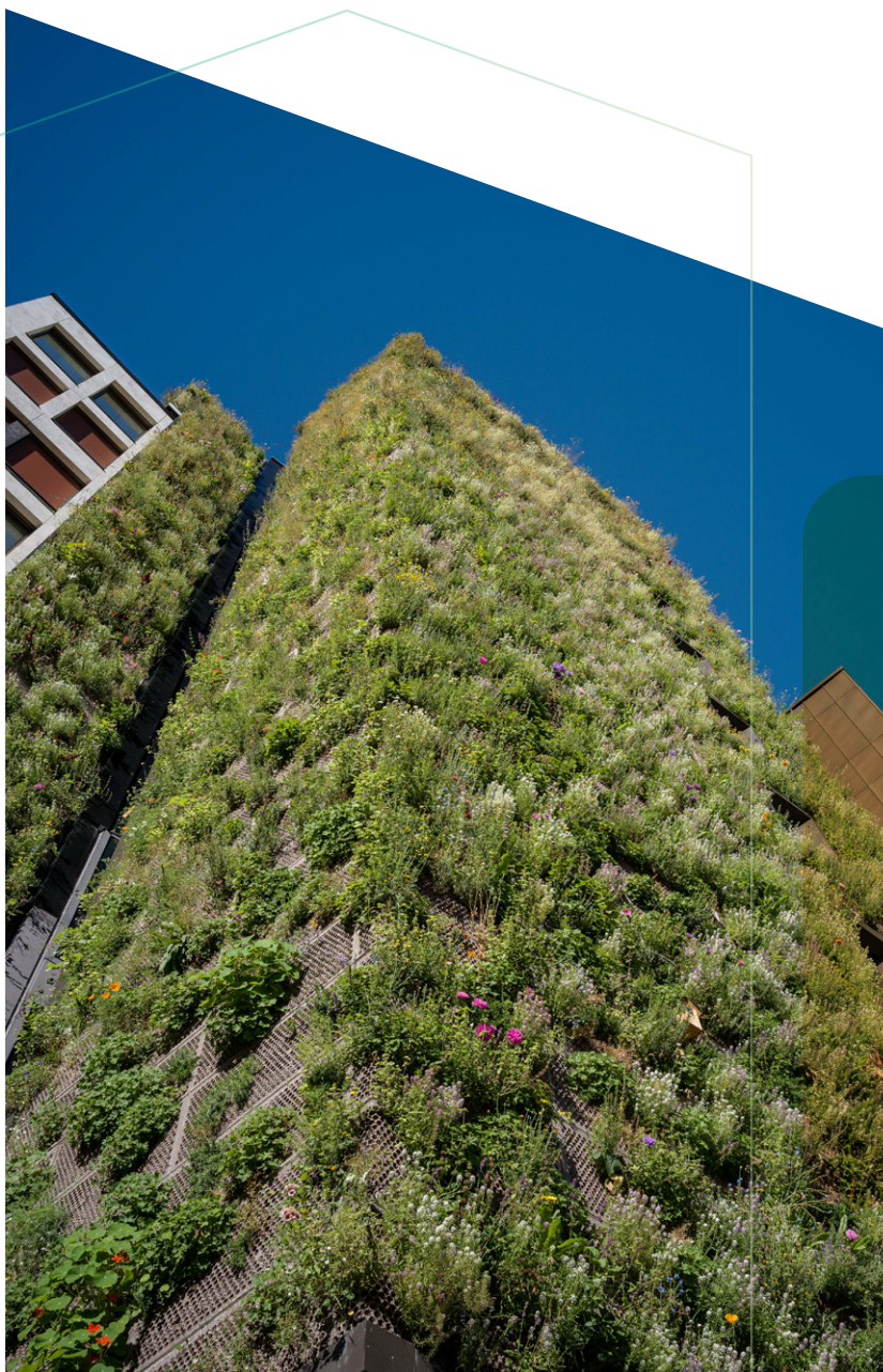
Stenersgata 1-3, Entra. BREEAM-NOR Excellent. Foto: Knut Neerland
