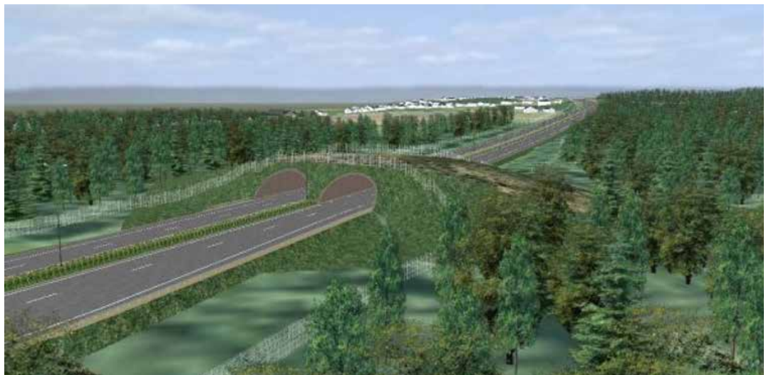
Figur 17. Kostbar faunapassasje hvor hele faunapassasjen blir en konstruksjon og terrenget ikke spiller på lag. Kilde Norconsult
