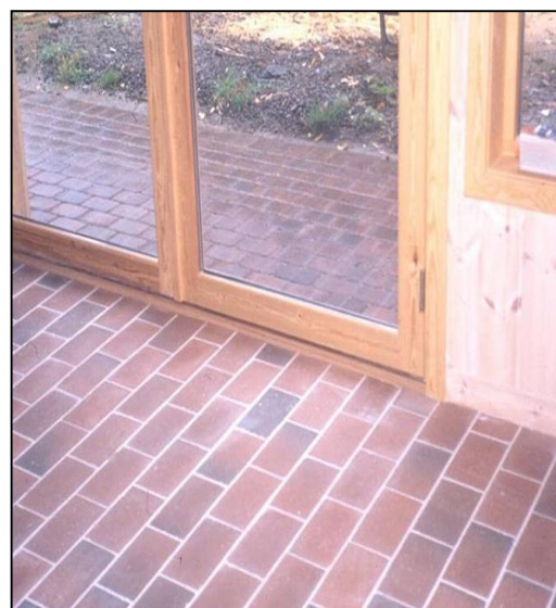
Teglfliser lagt i sand og demonterbart tregulv
