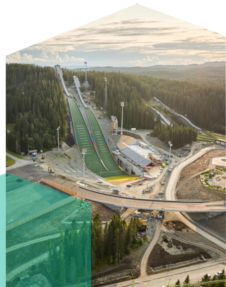
Granåsen idrettspark, NCC. Foto: NCC
