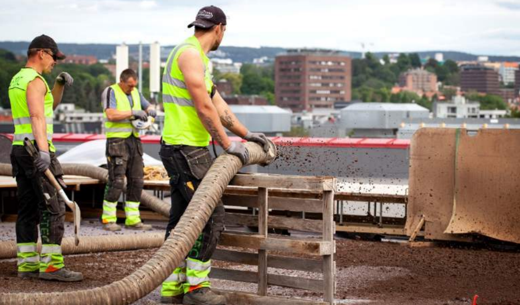
Jorden sprutes opp på taket 11.06.2019 – to dager etter var taket ferdig etablert
