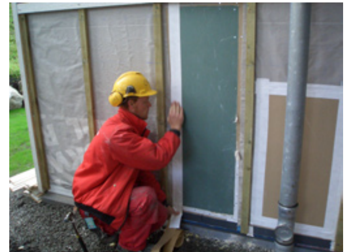
Nøyaktig tettarbeid ved passivhusprosjektet Løvåshagen i Bergen.
