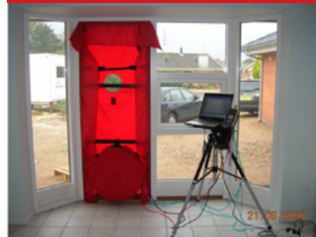
Trykktesting for å kontrollere tetthetsgrad av bygning
