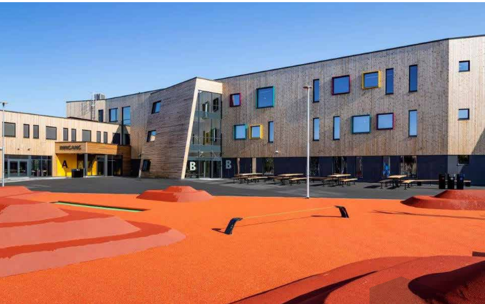
Hoppern skole i Moss er BREEAM-NOR-sertifisert til nivå Very Good. Foto: Helge Eek.
