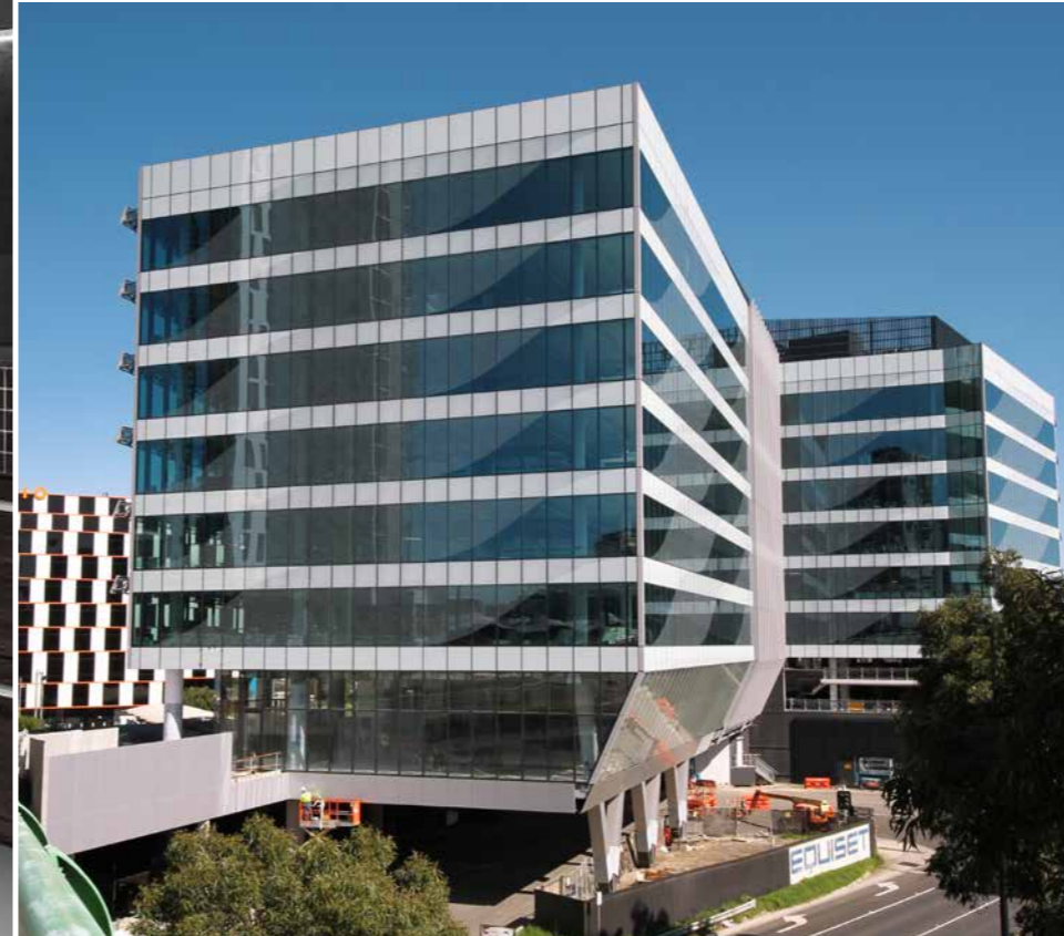
MELBOURNE WATER sitt nye kontorbygg i Australia stod ferdig i 2011, med 72 norske vakuumtoaletter. I Australia brukes «Green Star» systemet for grønne bygg, og her fikk nybygget selvsagt seks stjerner som er det maksimale man kan oppnå. Vakuumsystemet i bygget er dimensjonert for cirka 1.200 personer med to norskproduserte vakuumpumper. Men det er forberedt slik at en ekstra vakuumpumpe raskt og enkelt kan monteres inn, og da øker kapasiteten umiddelbart med 50%. Bygget er altså klart for eventuelle fremtidige utvidinger.
