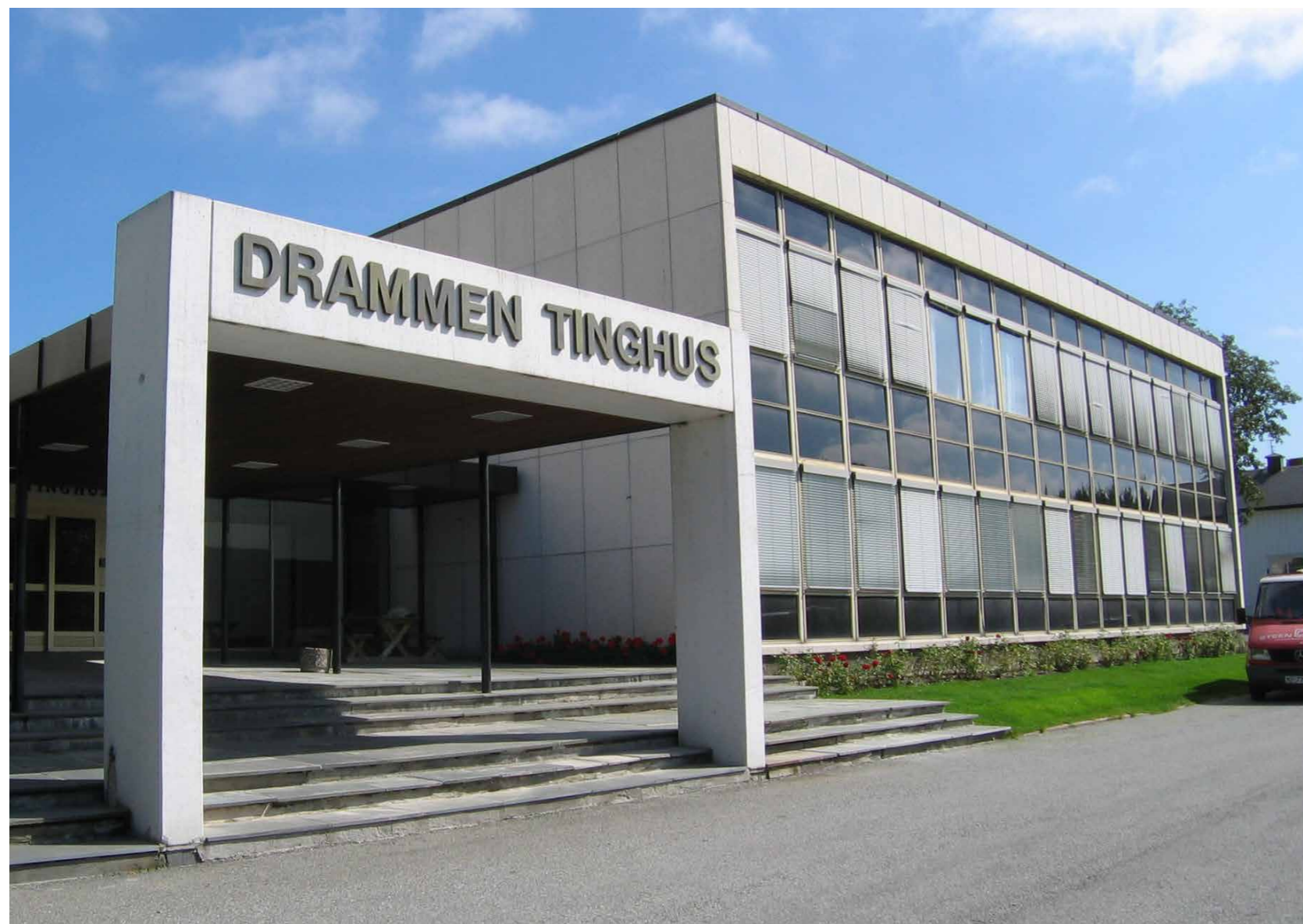
Cellene i Drammen tinghus er nå utstyrt med vakuuntoaletter for å gi innsatte bedre sanitærforhold. Arbeidet ble gjort i løpet av bare seks sommeruker, for ikke å forstyrre tingretten i samme bygg. Foto: Statsbygg.
