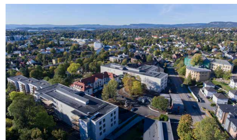
Ullerntunet helsehus er blitt et miljøvennlig bygg som det er godt å være i både for beboere, ansatte og pårørende.
