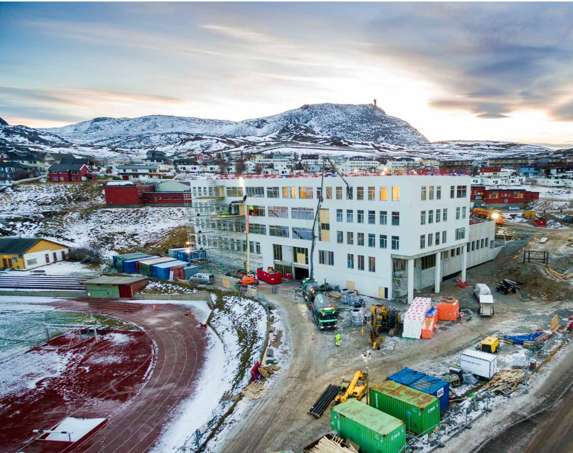
Nye Baksalen skole reiser seg i Hammerfest. Bygget skal BREEAM-NOR-sertifiseres.
