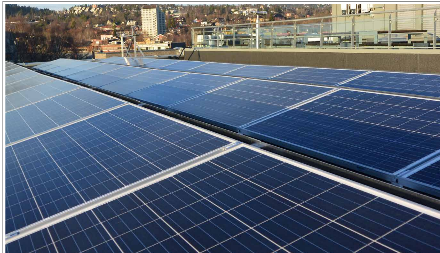
Montering av Solcellepaneler på Multiconsults hovedkontor.
