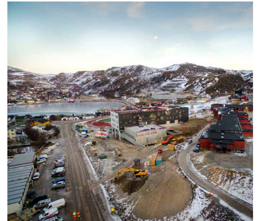
SKOLE under bygging.
