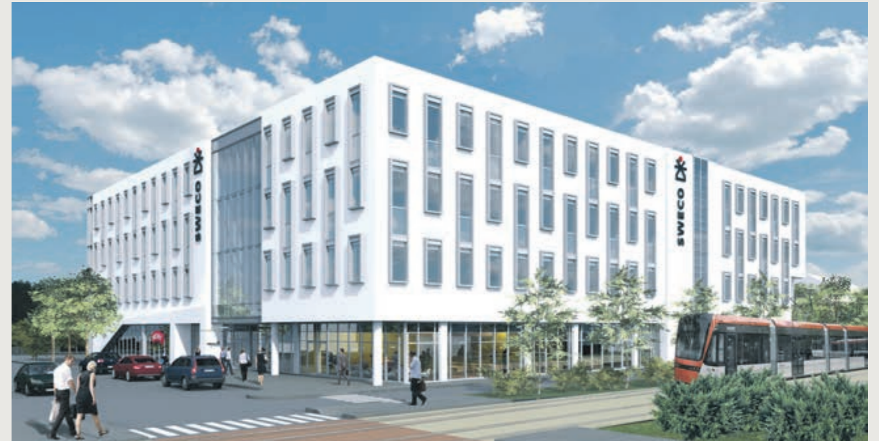
Sweco prosjekterer alle fag for nærings- og kontorbygget på Fantoft. Bygget står ferdig i 2016 med beste energiklasse (A). Samlet energibehov utgjør kun 50 % av kravet til klasse A.
