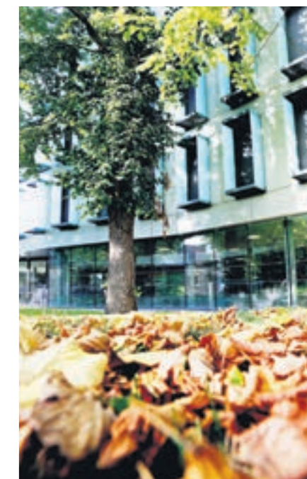
POENG: Munkedamsveien 62 har både grønt tak og fordøyningsanlegg i bakken, som er godt egnet for framtidens vær. Grøntanlegget bidro også til at prosjektet høstet mange poeng innenfor kategorien arealbruk og økologi.
