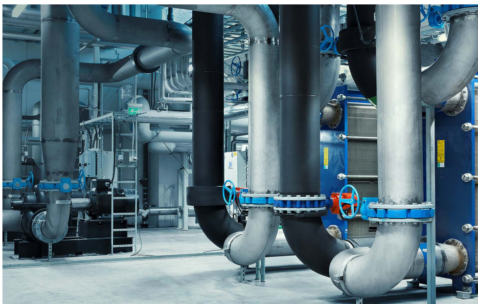
Avantor Energisentral i Nydalen.
