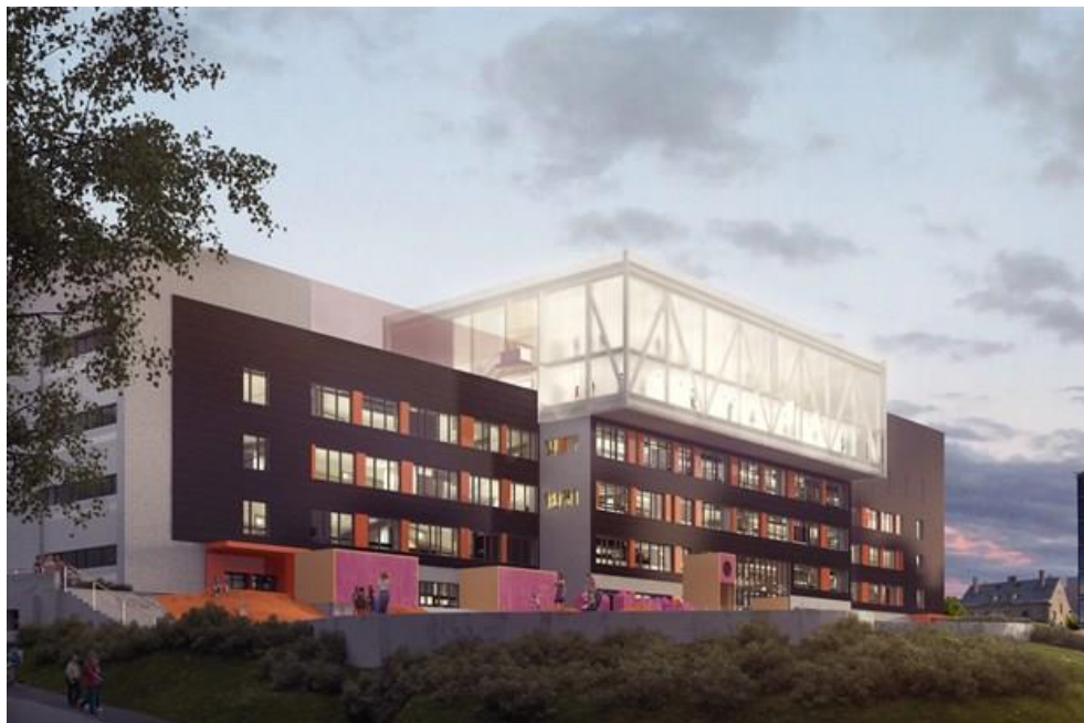
Brynseng skole ferdigstilles i 2017, byggherre Undervisningsbygg. Solcellearealet integrert i fasaden vil bli på 1000 m 2 og er beregnet å produsere 91 200 kWh pr år. Bildet er fra www.futurebuilt.no
