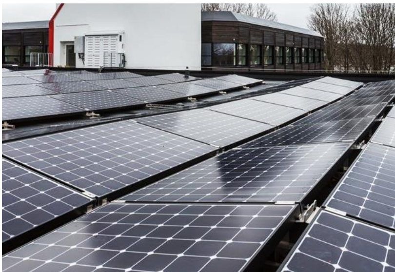
Powerhouse Kjørbo 2013, utstyrt med 1556 m 2 solceller som produserer 229 000 kWh pr år. Byggherre Entra Eiendom. Foto Tove Lauluten, www.futurebuilt.no
